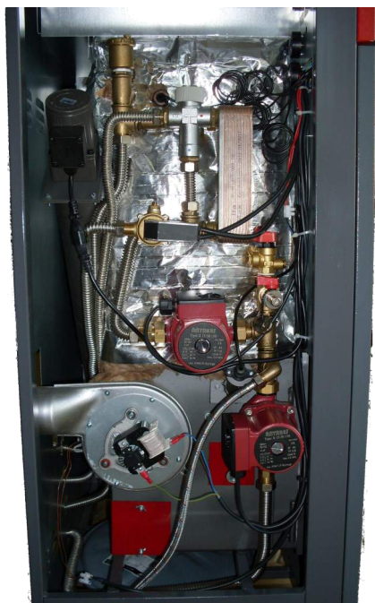
Kit hidráulico da caldeira com produção de águas quentes sanitárias instantâneas.
